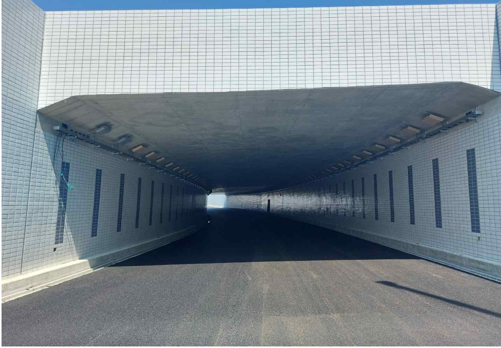
시점부 지하차도#1 전경
