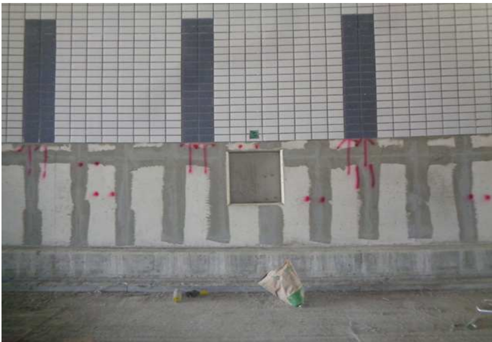
지하차도#1 소화기함 설치부 전경
