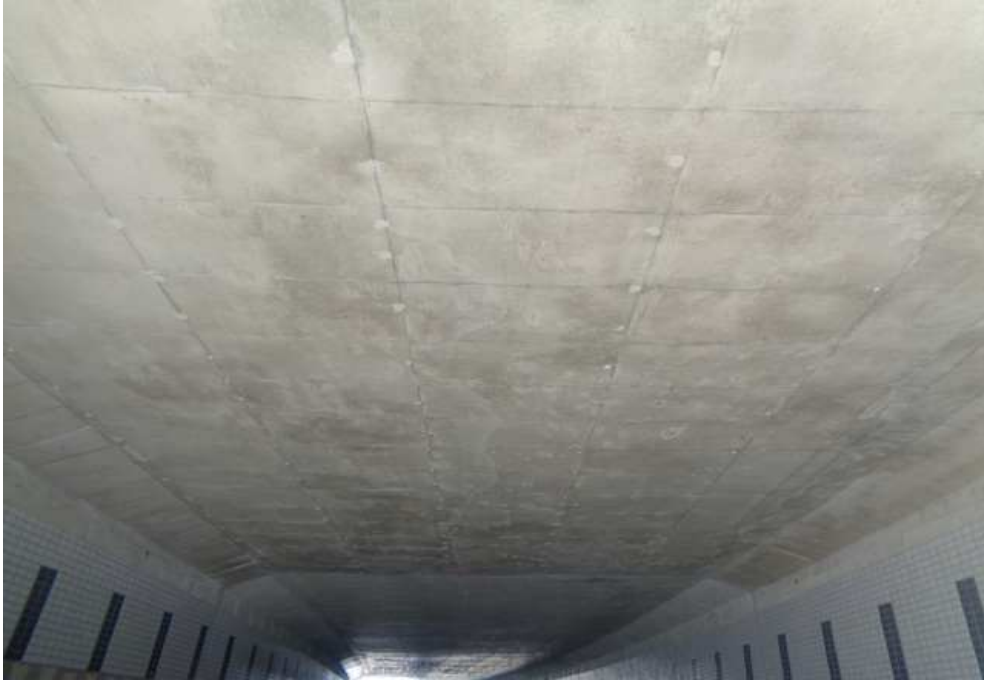
지하차도#1 상부슬래브 전경
