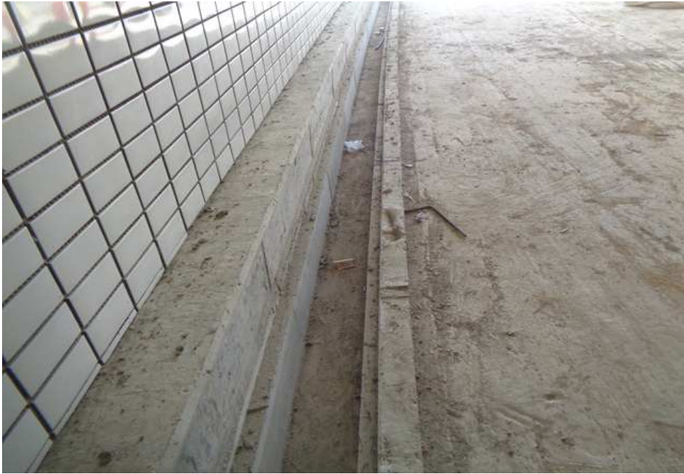
지하차도#1 배수로 전경
