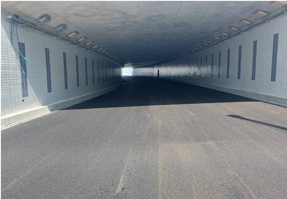
지하차도#1 벽체, 포장 전경
