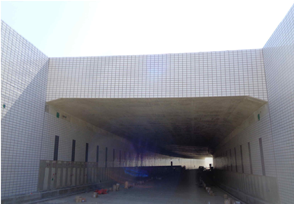
종점부 지하차도#1 전경
